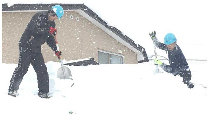
雪が降る中、屋根の上での作業を行う。
